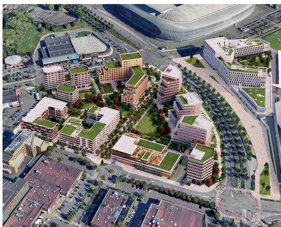
Novéa Parc project
